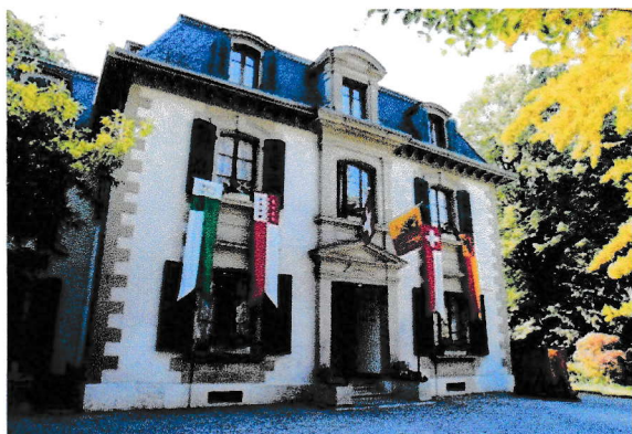
Entrée, côté Contamines
